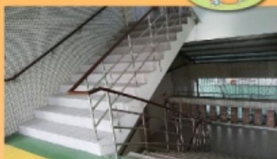
維修無障礙樓梯
